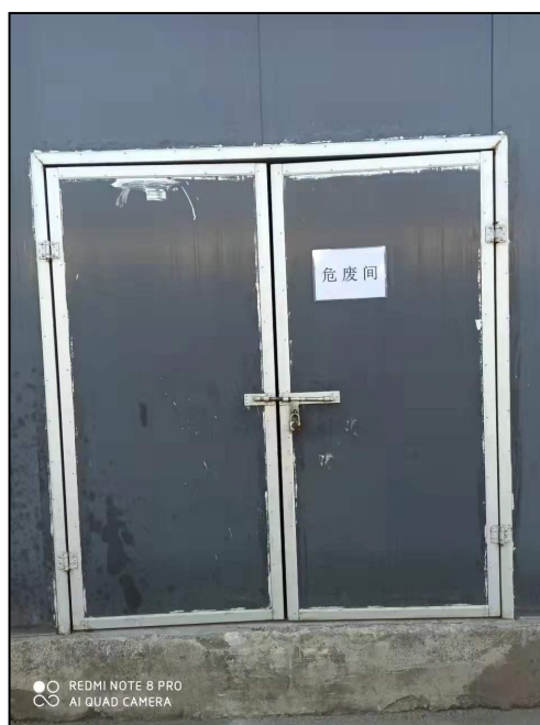
图 9 危险废物暂存间
