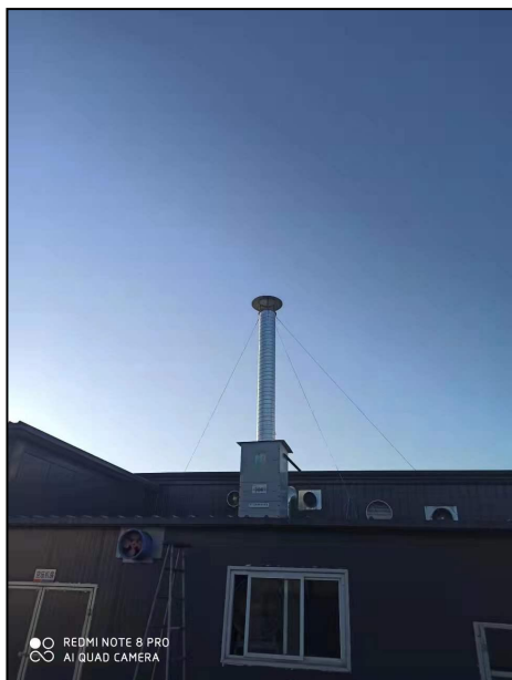
图 5 UV 光解装置+活性炭+15m 高排气筒
